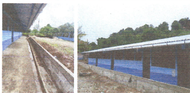
Foto 5: MURO DE CONTENCIÓN FINALIZADO, PARA PATIO DE ÁREA DE RECREACIÓN
