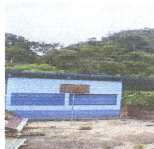
Foto 4: SE OBSERVA FINALIZADO EL ENTECHADO Y PINTURA EN COCINA
