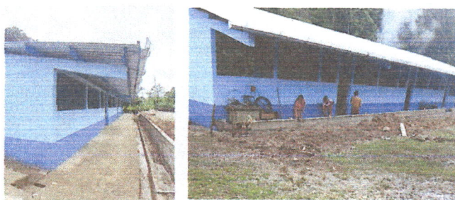
Foto 3: SUSTITUCIÓN DE PESCANTES Y CANALES DE AGUA PLUVIAL
