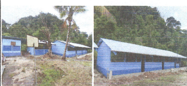
Foto 2: SE OBSERVA FINALIZADO EL ENTECHADO DE AULAS, COCINA, BAÑOS Y PINTURA EN TODAS LAS ÁREAS
